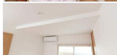
2部屋を1部屋にした寝室は、耐震のため、天井の梁を補強しましたが、違和感なくすっきりした内装に仕上げています。また、上階に住んでいる人の生活音を考慮して、天井の防音効果を図りウレタン吹き付けを行っています。
