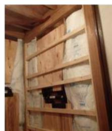
実際に施行されたHiダイナミック制震工法柱取付型の様子
