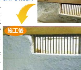
パワーアラストはコンクリートへの接着性、機械物性、耐水性に優れたエポキシ樹脂にアラミド繊維等の有機繊維やガラス繊維等の無機繊維を配合した優れた補強・補修材です。劣化したコンクリートを新築時と同等もしくはそれ以上に回復させます。
